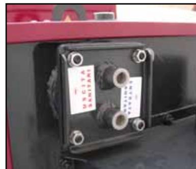
Installare in entrata ed in uscita, sullo scambiatore sanitario, due prese per un eventuale lavaggio chimico contro il calcare. Nel caso in cui ci sia la certezza di un'elevata durezza dell'acqua, applicare un idoneo sistema anticalcare.
